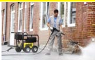
Limpieza de edificios
